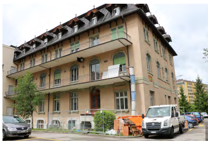
Haus Pérolles 38 in Freiburg: (Foto: ME) oben: Seite Pérolles mit Haupteingang (Mitte) unten: Seite Hof
